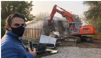
Mercoledì 21 ottobre 2020 inizia la demolizione del vecchio Nido Comunale
