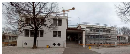
Lavori in corso alla scuola secondaria di primo grado "Belludi"
