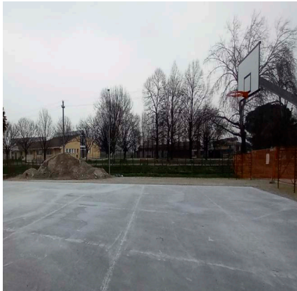
La nuova piastra di Presina in attesa della pavimentazione
